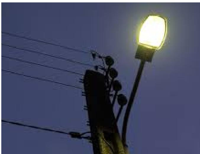
La deuxième tranche de remplacement des ampoules sodium haute pression 150 watt par des LED de 38 watt équipe aujourd'hui la totalité du village
